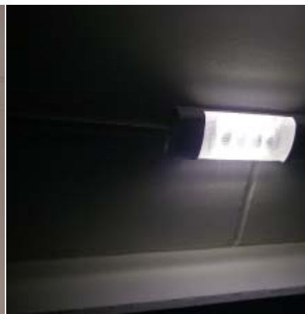
Перед лифтом энергосберегающий светильник работает от датчика на движение. Как это нравится деткам.
